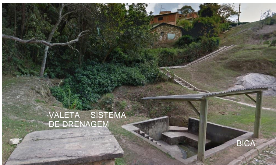
Foto 1: Bica construída a jusante da Mata da Caixinha e valeta em terreno que recebe água de chuva. Fonte: Consominas, 2016.
